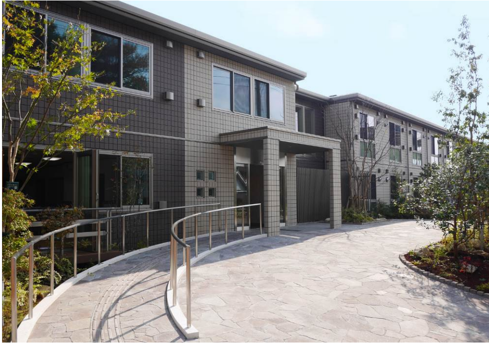
サービス付き高齢者向け住宅『ハイムガーデン立川幸町』外観
