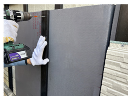
断熱材を固定
