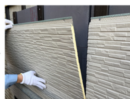
ガルバリウム鋼板(仕上げ材)を取り付け
