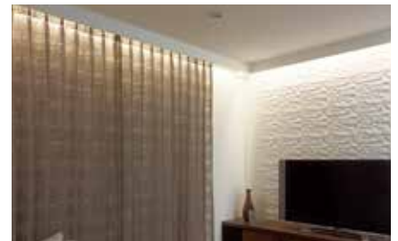
128 CORNICE LIGHTING LEDコーニス照明
